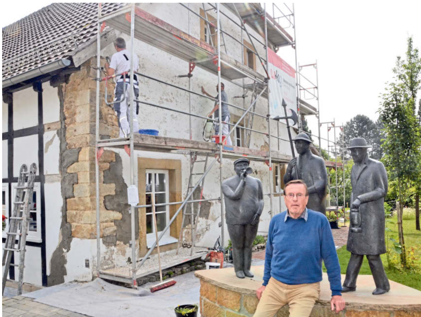
Carl-Heinz Beune staunte auch nicht schlecht, was die Sanierung an der westlichen Wand des Kultur- und Heimathauses zu Tage förderte. Kurzentschlossen entschied er, dass die alten Steine zum Teil künftig sichtbar bleiben sollen. Vermutlich sind sie noch deutlich älter als das Haus, das aus dem Jahr 1799 stammt.
