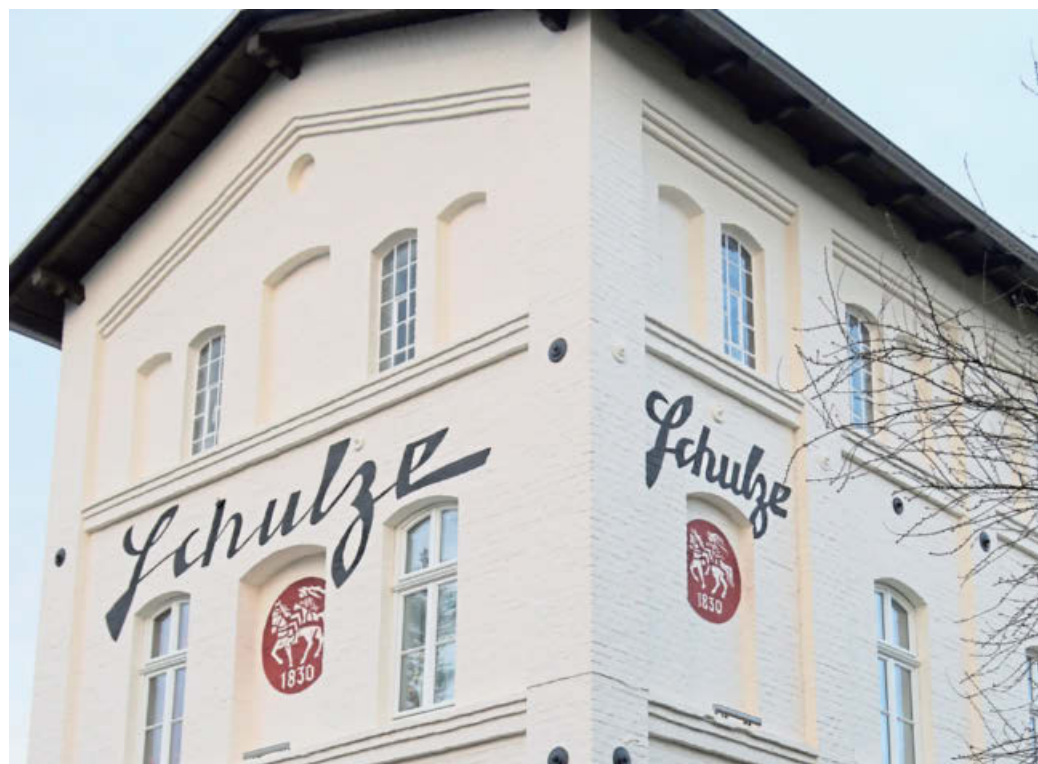
Frisch renoviert erstrahlt das Kontorhaus am Haller Weg. Auch das traditionelle Schulze-Logo wurde überarbeitet. Hier soll dem Heimatverein nun bald ein Raum als Archiv zur Verfügung gestellt werden.
