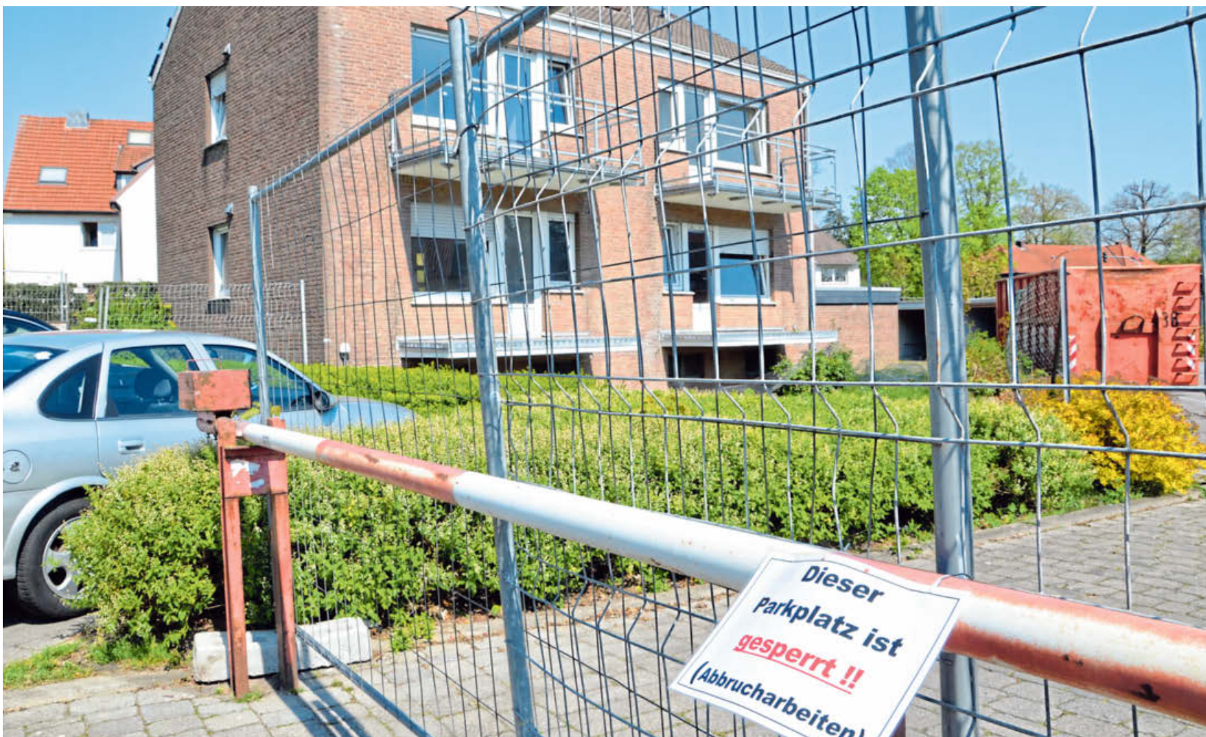
Jetzt geht's los: Dann soll der Bagger rollen und mit dem Abriss beginnen. Drei Gebäude müssen weichen, um Platz für den Netto-Markt zu schaffen. FOTO: ANDREAS GROSSPIETSCH
