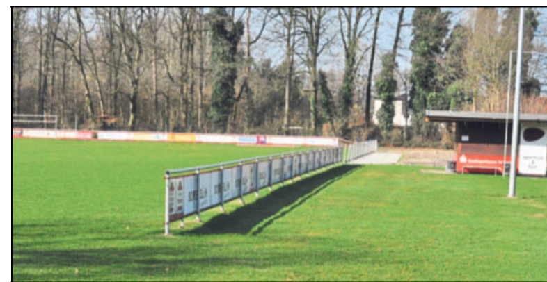
Im Wöstenstadion soll eine Tribüne mit 56 Sitzplätzen gebaut werden. Die entsprechende Fläche ist bereits geplant. Mit knapp 40 000 Euro kalkuliert der SCP diese Baumaßnahme.
