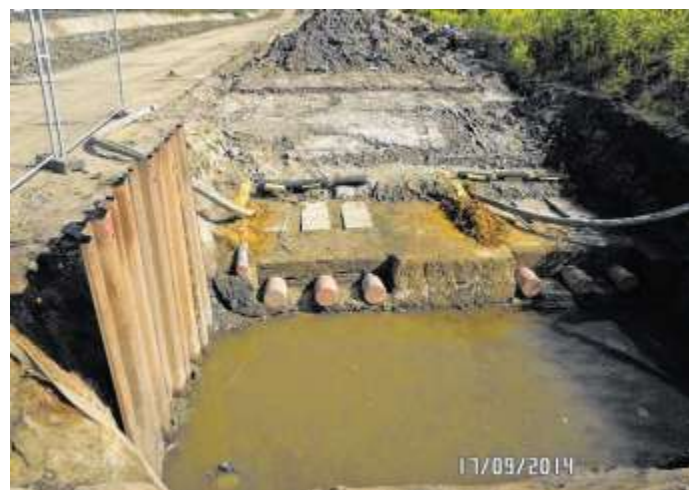
Erdverkabelung in der Praxis: Links der mit Metallplatten abgedeckte Fahrstreifen für den Bagger, rechts ein Blick in die Situation in der Erde. Die Oberkante der Konstruktion aus Rohren und Schutzschicht liegt am Ende der Bauarbeiten in 1,80 Metern Tiefe. FOTO: HK
