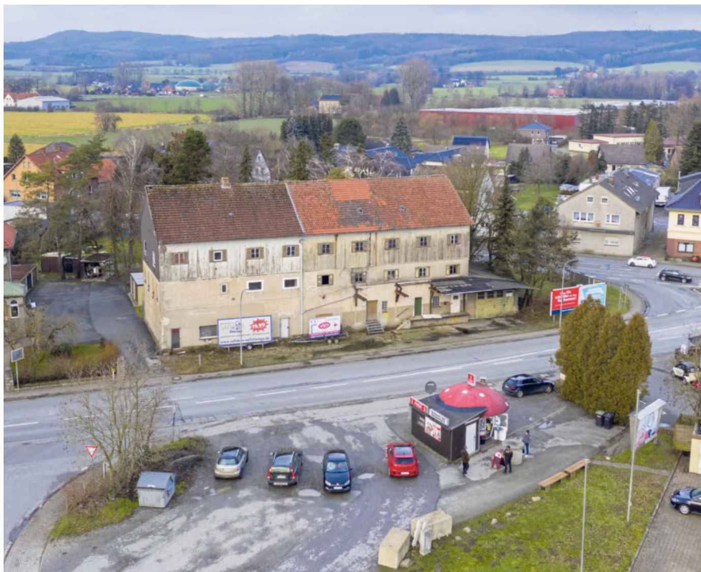
In dieser Woche beginnt der Abriss des alten Kornspeichers am Borgholzhausener Bahnhof. Die dazugehörige Mühle wurde nach einem Brand im Jahr 1975 abgerissen und machte Platz für den legendären Pilz-Imbiss. Archivbild: Ulrich Fälder
