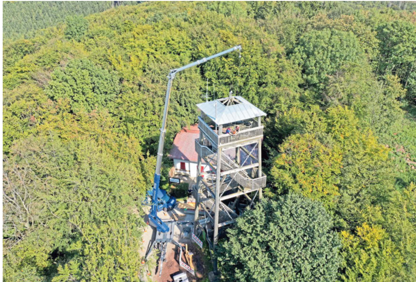
Die Reparaturarbeiten am Luisenturm waren von der Zimmerei Thöle mit Hilfe des Mobilkrans schnell erledigt. Das Arbeitsgerät reichte auch noch, wenn das Wahrzeichen zehn Meter höher wäre.
