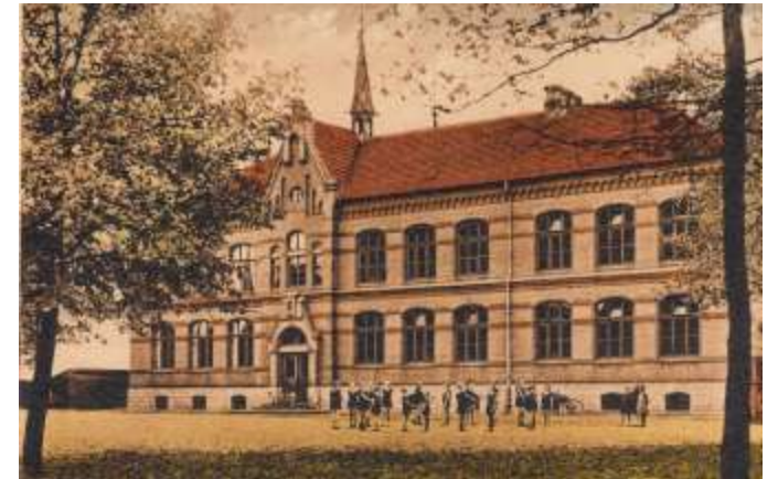
Vergangenheit: Die alte Volksschule war ein äußerlich imposanter Bau. Heute steht an dieser Stelle des Rathaus der Stadt.
